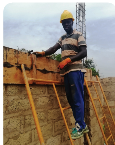
Stagiaire en insertion dans une entreprise de maçonnerie (GB)
