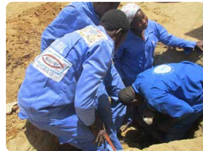
JOVENS EM FORMAÇÃO DE CONSTRUÇÃO CIVIL - CHADE
